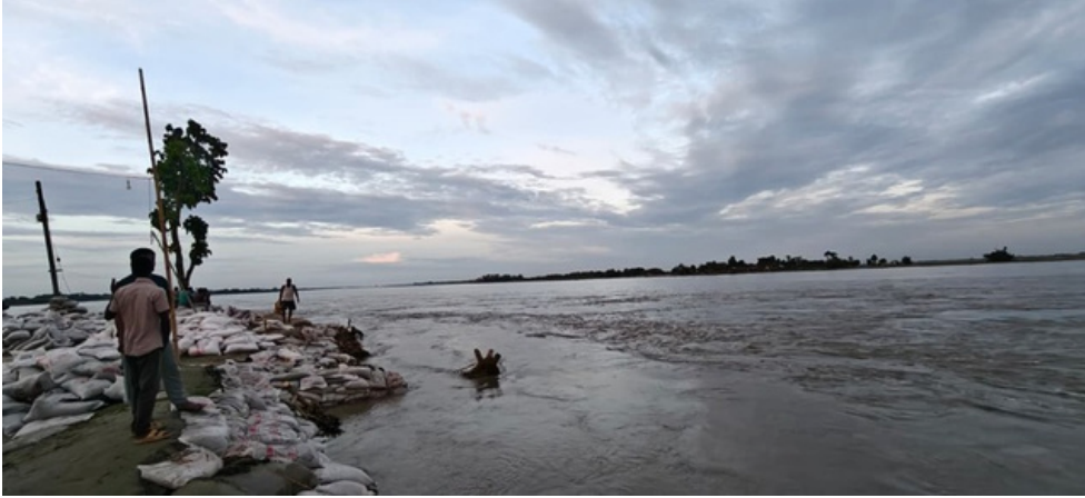
चित्र 5: कटाव को रोकने के लिए नदी के किनारे चल रहा बाढ़ संघर्षात्मक कार्य
